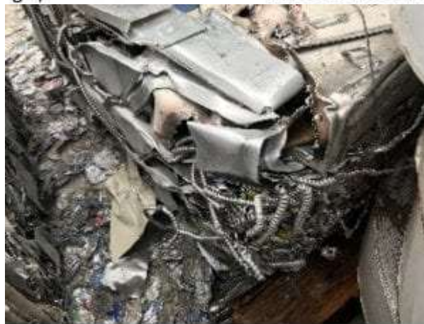
Pipe and Conduit
