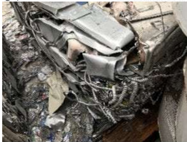
Pipe and Conduit
